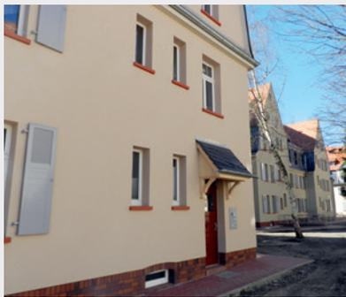
wurden zudem die Kelleraußentreppen sowie die Kellerverschläge. Neue Dämmungen erhielten die Fassade mit 70 mm Resolhartschaum und die oberste Geschossdecke begebar mit 180 mm. Bei den Zugängen zum Keller und zur Mansarde wurden T-30 Türen installiert.
