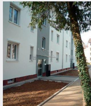
außentreppen erneuert, Kellerverschläge aus Metall installiert und T-30 Türen zum Keller angebracht. Die Fassade wurde mit 160 mm Mineralwolle und die oberste Geschossdecke begebar mit 140 mm isoliert. Darüber hinaus erfolgte der Einbau von neuen, dreifachverglasten Fenstern und Vorsatzrollläden in allen Geschossen sowie einer neuen Sprechanlage in allen Wohnungen.
