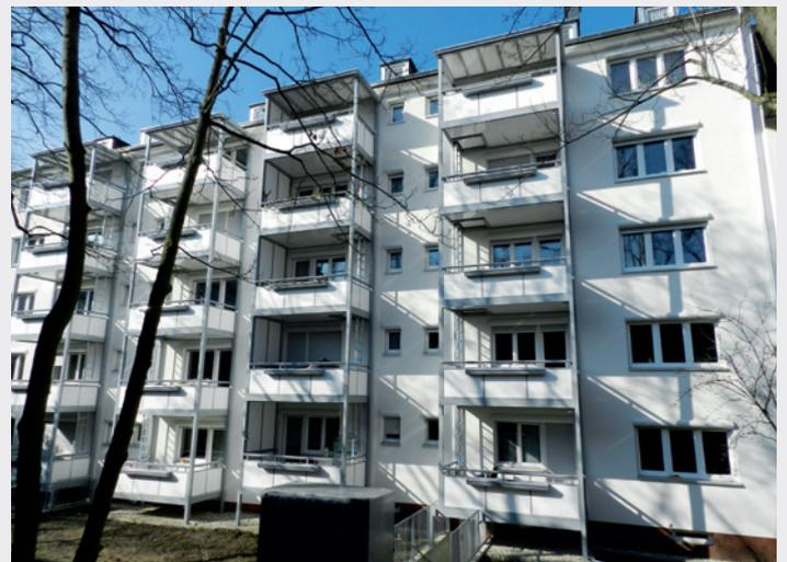
wurden folgende Maßnahmen durchgeführt: Der Einbau einer Zentralheizung mit Brennwerttechnik und Warmwasserversorgung über Etagenstationen, der Einbau einer zentralen Wohnraumlüftung (Abluftanlage), eine im Garten befindliche Luft-Wasser-Wärmepumpe, die Kelleraußenwandabdichtung auf der Gartenseite und die Dämmung von Fassade, Kellerdecke und der obersten Geschossdecke mit Begehung sowie 3-fachverglaste Fenster in allen Wohnungen.
